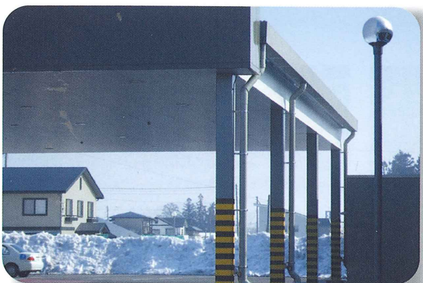
米沢市事務所棟
