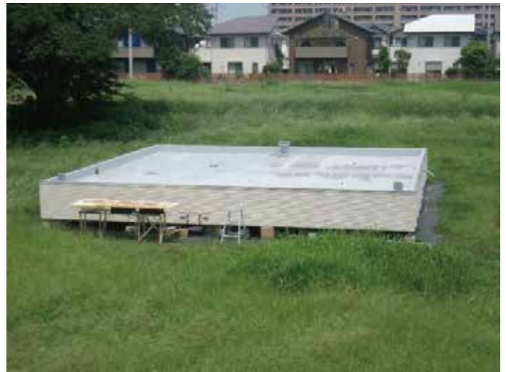
検証施設：散水したCLTパネルに防水施工後、水分を除去
