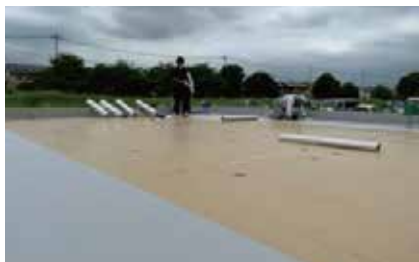
5.防水シート設置
