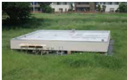
6.脱気筒・吸気筒設置し完成
