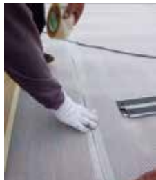
2.通気層目地処理
