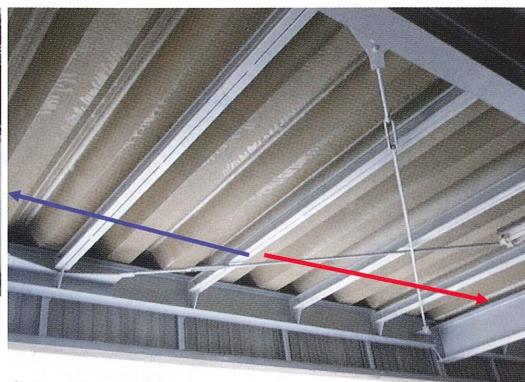
【天井面の状況】
