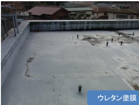
◆ウレタン塗膜防水の脱気筒設置例
