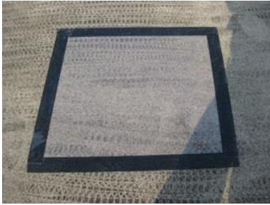
透明シートを施工
