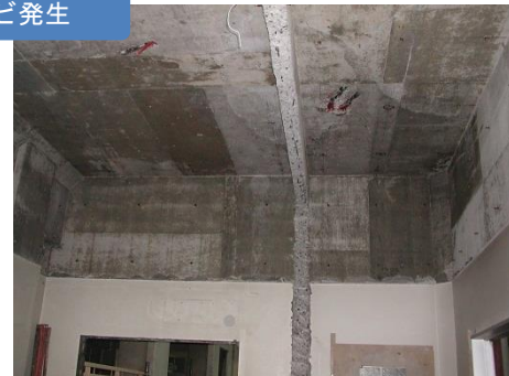
◆左記現場の室内側コンクリートの表面。大量のカビが発生。
