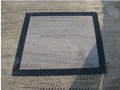
透明シートを施工
