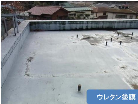
◆ウレタン塗膜防水の脱気筒設置例
