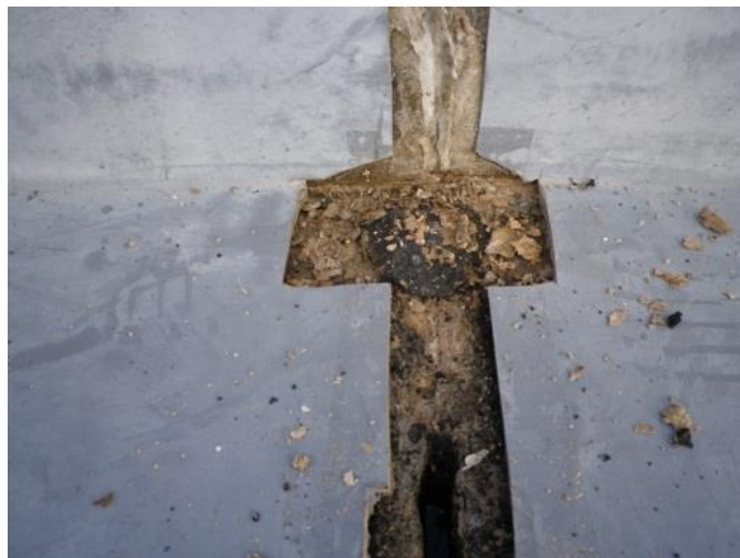
防水層内のコンクリートが劣化した箇所
