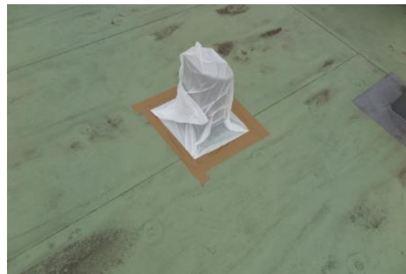
吸気筒は袋をかぶせ、吸入しないように気密処理。
