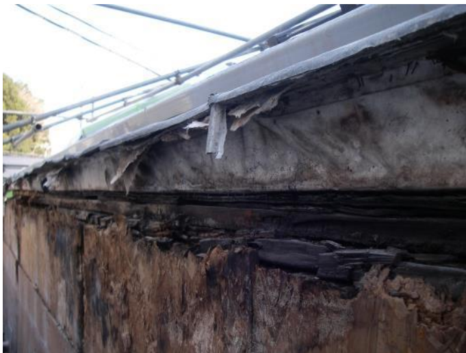
屋根・壁を一体型防水工法 2×4住宅の構造壁、断熱材が劣化。
