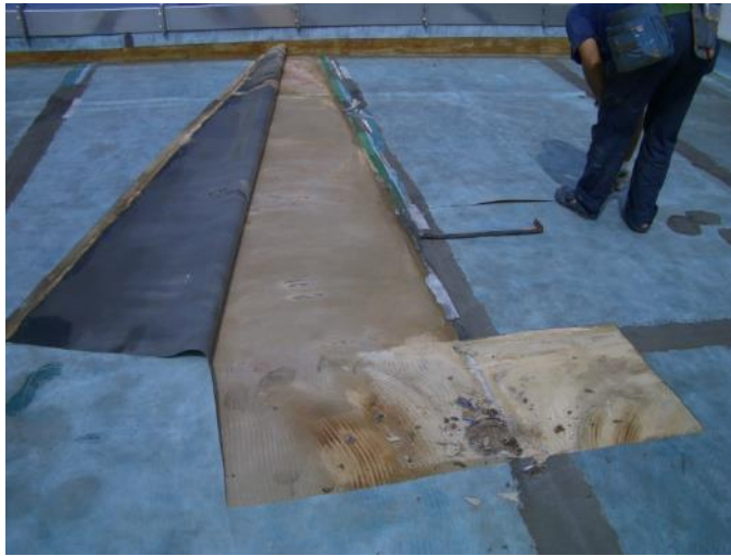
防水層内のコンクリートが劣化
