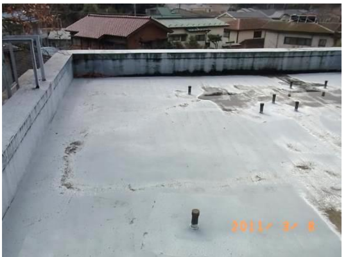
防水層内に水が入り脱気が困難な箇所
