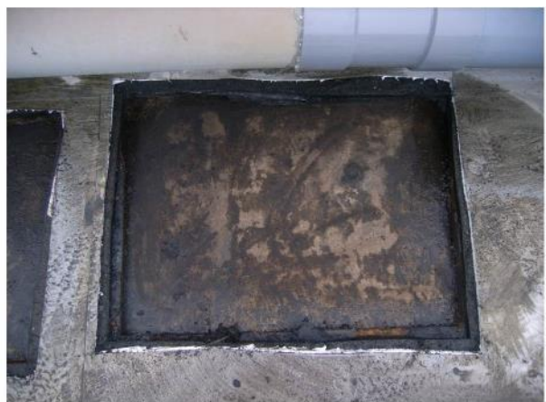
断熱材が水を包含。
