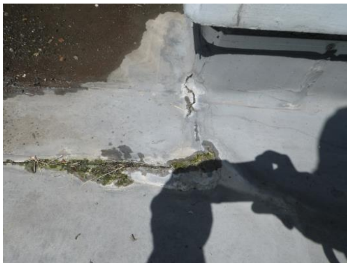
防水層が切れ、苔が発生した箇所
