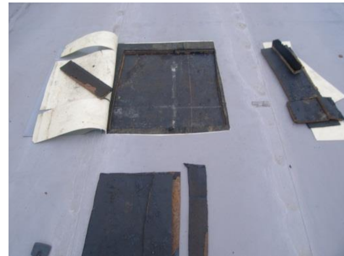
断熱材に水が含浸した例：アスファルト防水断熱仕様に塩ビシート防水を施工。
