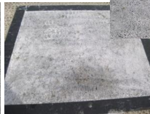
22日経過 多量の結露が発生
