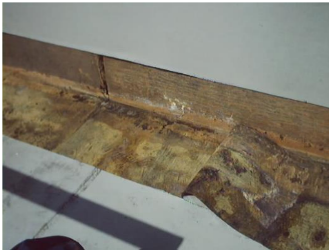
防水層内がカビで変色
