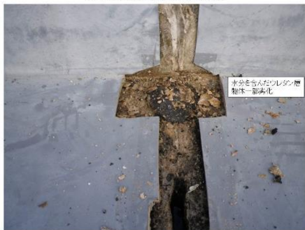
コンクリートの劣化が確認
