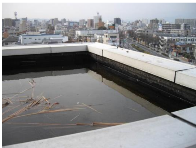
防水層の排水口が詰まり、プール状態。
