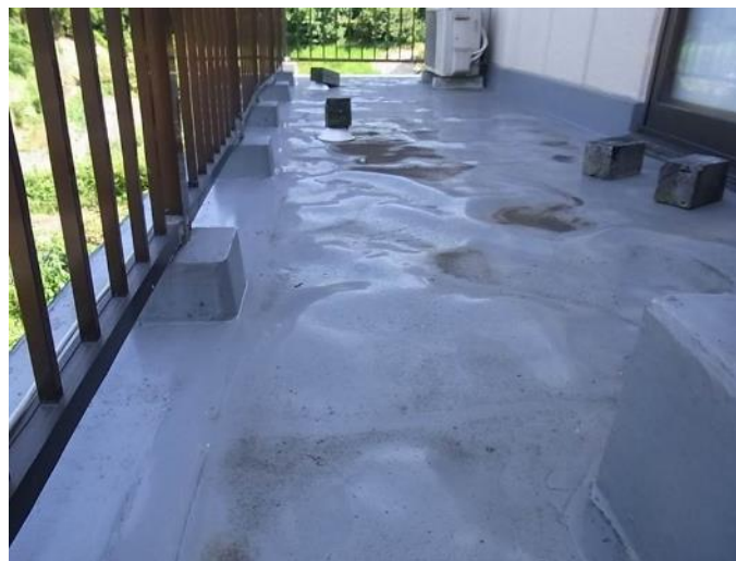
防水層の膨れ
