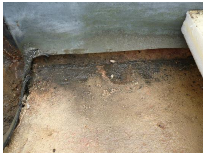
防水層内のコンクリートが劣化。
