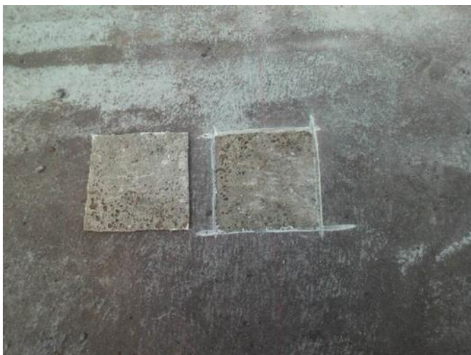
防水層内のコンクリートが劣化。
