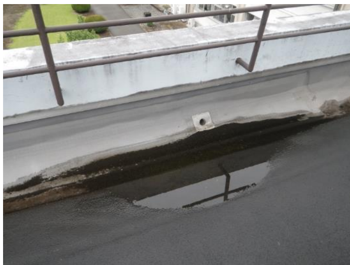
防水層が変形し、水が溜まっている。
