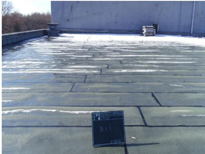
施工中（コアコーン通気材敷きこみ）
