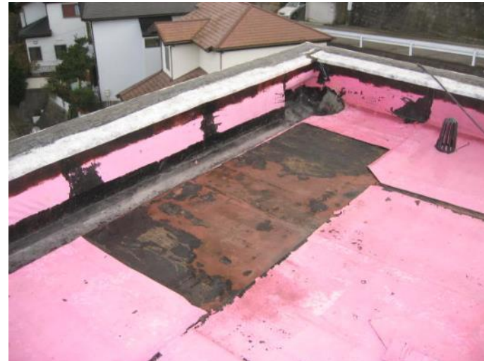
防水層内がカビで変色
