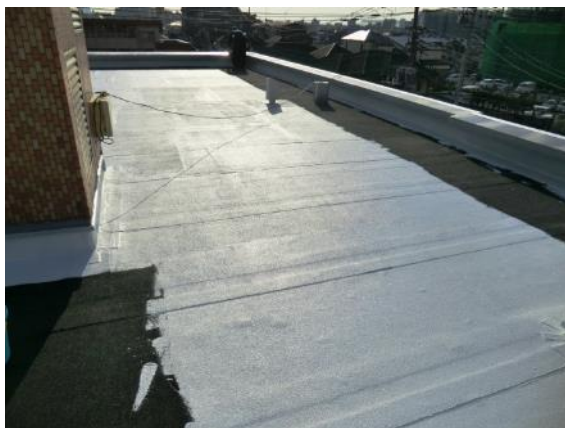
完成（改質アス2層目、トップ塗布中）
