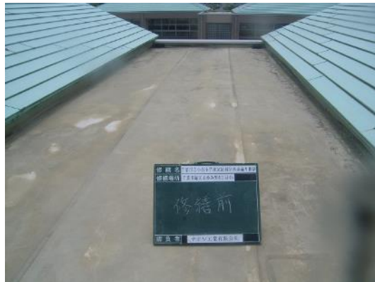
施工前（ウレタン防水）
