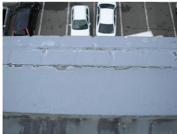
防水層が切れ、タイル壁の中に浸水している箇所
