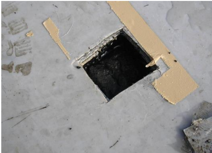
防水層内に大量の水。
