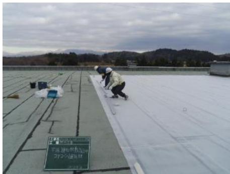
施工中（コアコーン通気材敷きこみ）
