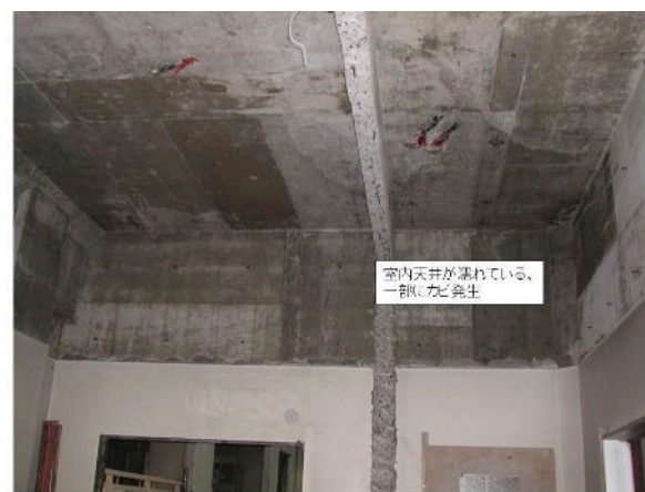
左写真の防水層下の天井にカビが発生。
