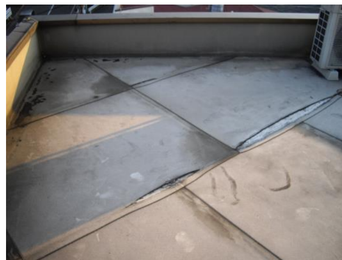
防水層が切れた箇所
