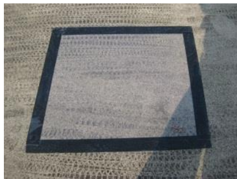
透明シートを施工
