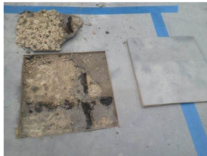
防水層内のコンクリートが劣化。
