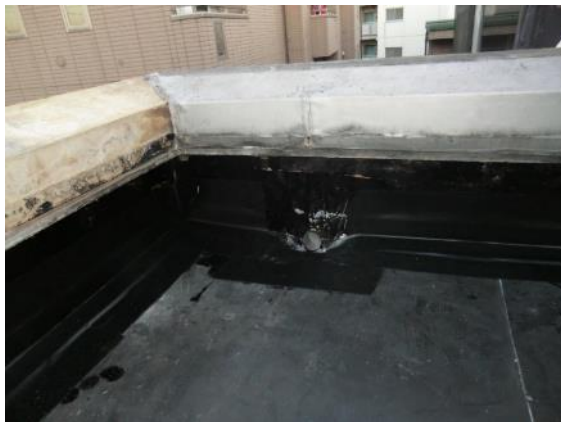
施工前（既存防水撤去）
