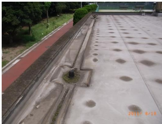
防水層の変形、排水口に水草、
