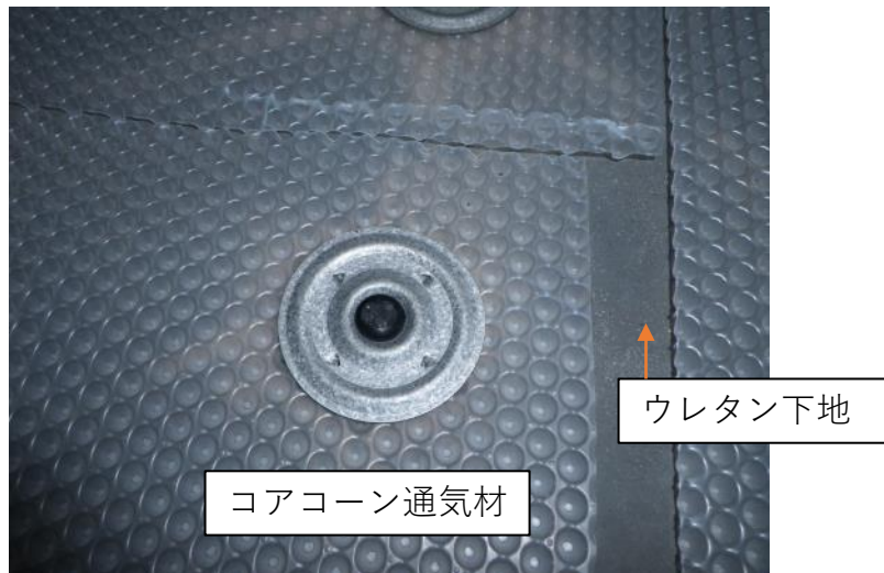
施工中（コアコーン通気材+通気緩衝シート敷きこみ）
