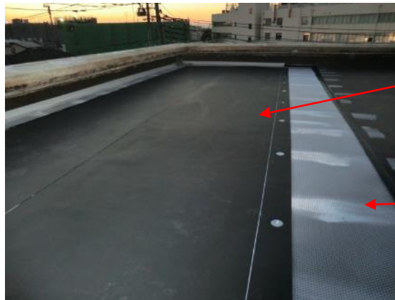
施工中（通気材敷きこみ）
