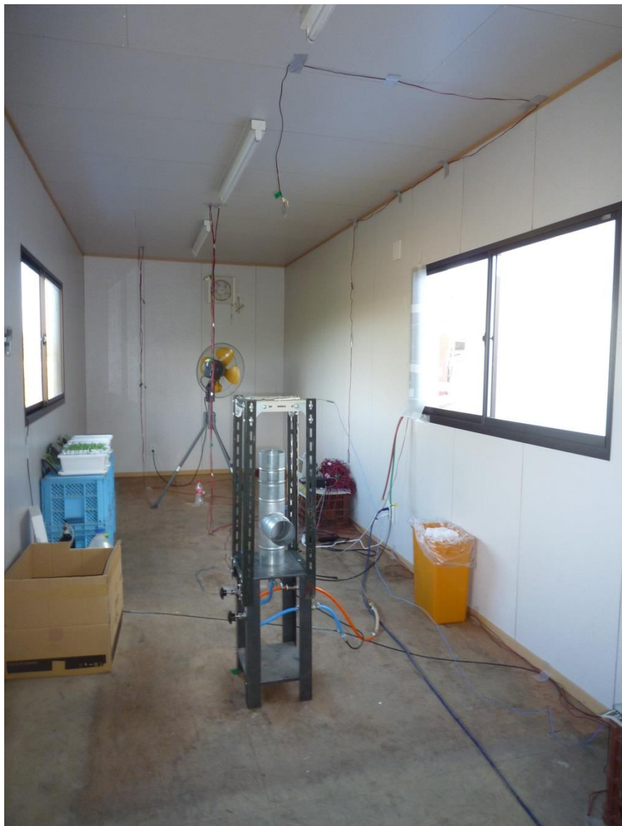
水素加温機棟
