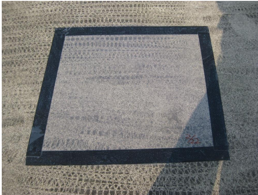
平成24年2月14日防湿シート設置
