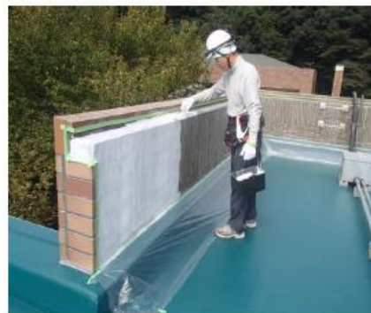
件名: 屋上防水改修工事 (標本倉庫上部) 部位: 屋上 内容: 塗装工事 施工前 下塗り状況
