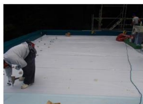
件名: 屋上防水改修工事 (標本倉庫上部) 部位: 屋上 内容: 防水工事 コアコーン敷き込み状況
