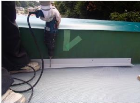
件名: 屋上防水改修工事 (標本倉庫上部) 部位: 屋上 内容: 防水工事 既存防水膨れ部是正 施工状況
