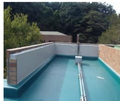
件名: 屋上防水改修工事 (標本倉庫上部) 部位: 屋上 内容: 塗装工事 施工前 上塗り完了
