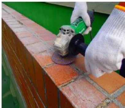
件名: 屋上防水改修工事 (標本倉庫上部) 部位: 屋上 内容: 塗装工事 ケレン状況
