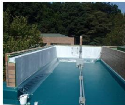
件名: 屋上防水改修工事 (標本倉庫上部) 部位: 屋上 内容: 塗装工事 施工前 下塗り完了
