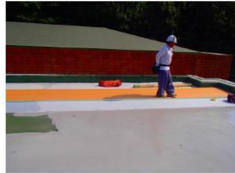
件名: 屋上防水改修工事 (標本倉庫上部) 部位: 屋上 内容: 防水工事 コアコーン敷き込み 断熱材敷き込み
