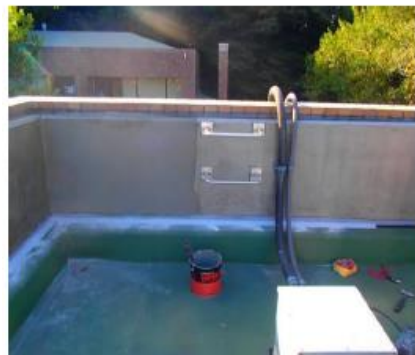
件名: 屋上防水改修工事 (標本倉庫上部) 部位: 屋上 内容: 塗装工事 施工前 下地調整
