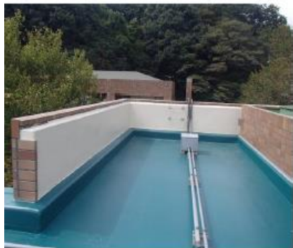
件名: 屋上防水改修工事 (標本倉庫上部) 部位: 屋上 内容: 塗装工事 施工前 中塗り状況
