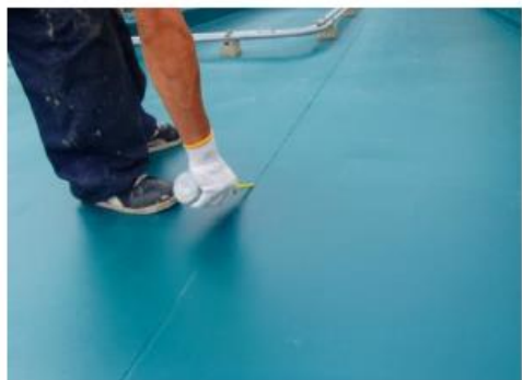
件名: 屋上防水改修工事 (標本倉庫上部) 部位: 屋上 内容: 防水工事 ジョイント部分充填
