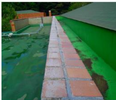
件名: 屋上防水改修工事 (標本倉庫上部) 部位: 屋上 内容: 塗装工事 施工前
