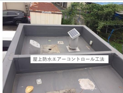
コンクリート下地乾燥状態: (塩ビシート防水・AC工法)
