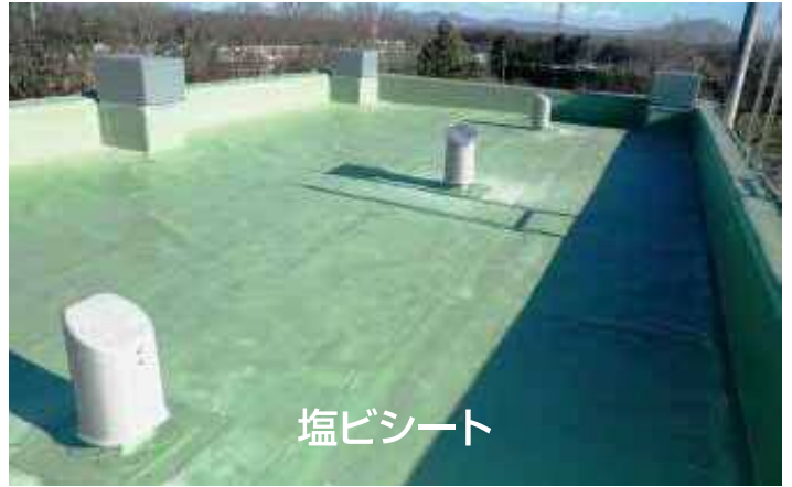
機械固定シート防水工法
