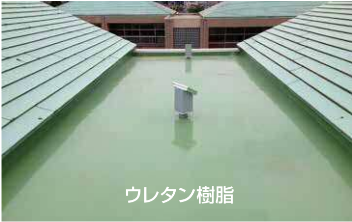
塗膜系防水工法
