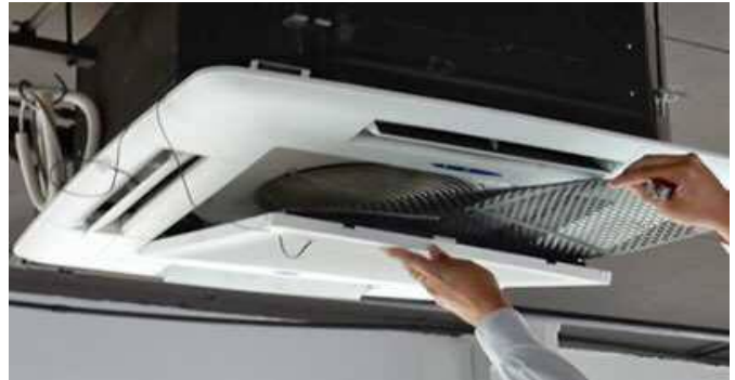
室内機取付-2 天カセ（4方向吹き出し）
