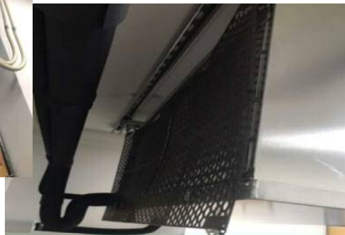
冷凍・冷蔵庫取付-1（背面の吸い込みへ設置）
