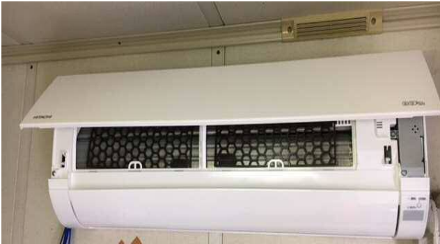
室内機取付-1 ルームエアコン
