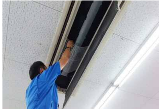
室内機取付-4 天カセ（2方向吹き出し）
