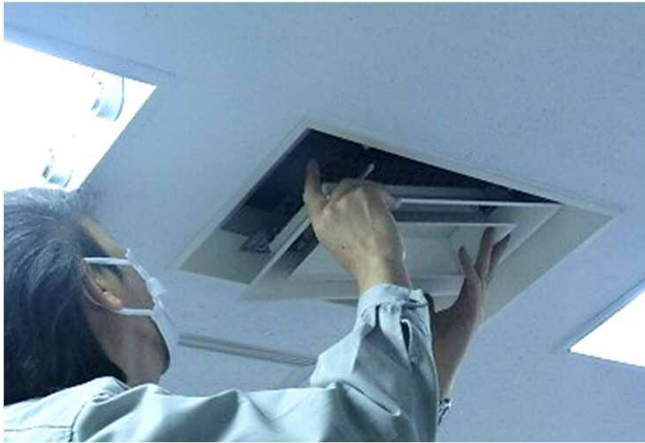
室内機取付-3 ダクト式
