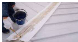
棟のFRPライニング
