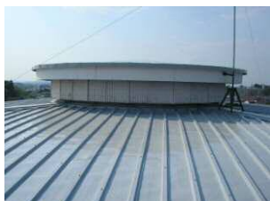
ドーム瓦棒屋根
