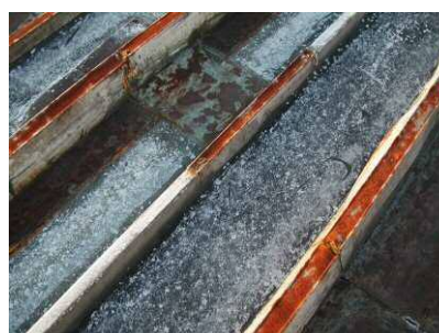
工場 瓦棒屋根
