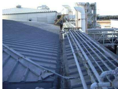
工場 瓦棒屋根
