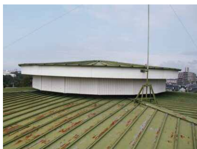
ドーム型 体育館 瓦棒屋根
