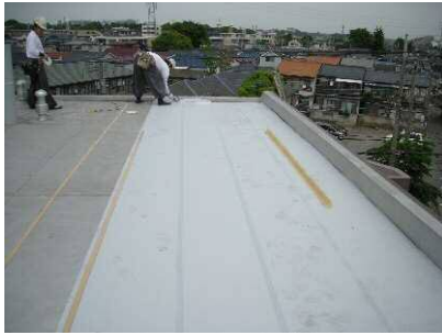
ブチルゴムテープ施工
