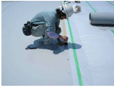
ブチルゴムテープ施工
