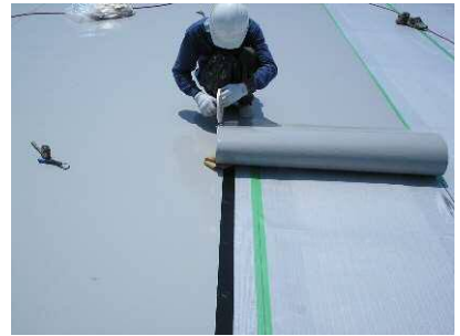
重ね上シートに弾性接着剤・ 構造用テープ施工
