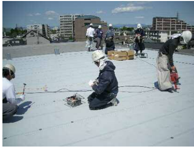
FRPシートをアンカー固定
