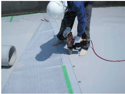
FRPシートをアンカー固定
