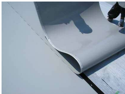
接着部材取り付け完成
