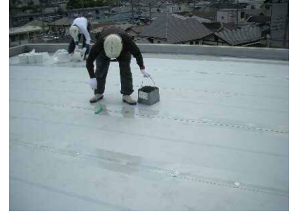
FRPライニング部にプライマー塗布
