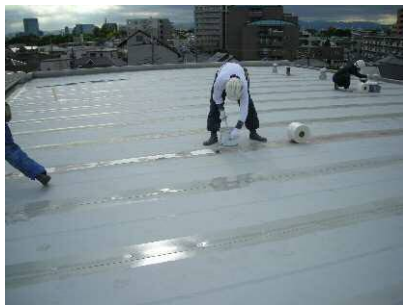
FRPライニング
