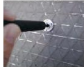
アンカーピン打込み
