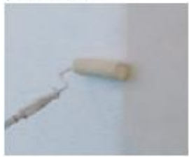
仕上げ材施工
